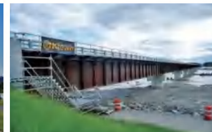
■ 美国阿拉斯加铁路桥 Tanana river Bridge, Alaska in USA
