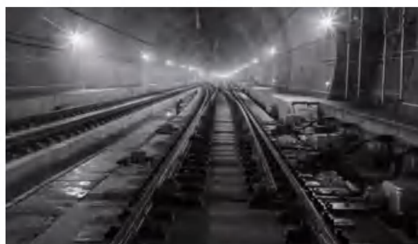
■ 时速350公里60kg/m钢轨18号可动心轨高速道岔, 道岔全长69米, 侧向通过时速80公里 60kg/m No.18 movable-nose high-speed turnouts, Total length:69m, Straight speed:350km/h, Divergent speed:80km/h
