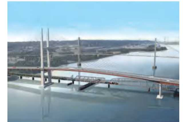
加拿大帕特洛大桥 The Paltrow Bridge in Canada
