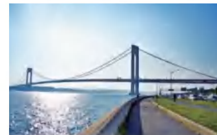
■ 美国韦拉扎诺海峡大桥（维修项目） Verrazano-Narrows Bridge in New York USA(Upper Deck Replacement)
