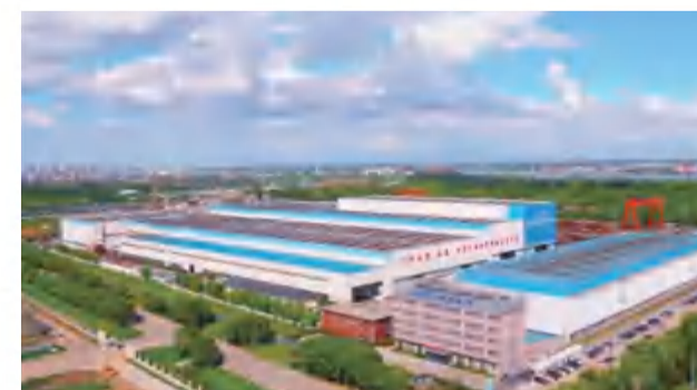
中铁山桥（南通）有限公司（南通基地） CRSBG (Nantong) Heavy Industry Co., Ltd. (Nantong Base) in Jiangsu Province
