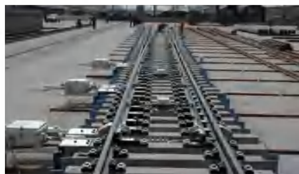
■ 时速200公里60kg/m钢轨18号无砟道岔 200km/h with rail 60kg/m No.18 turnouts (non-ballast)
